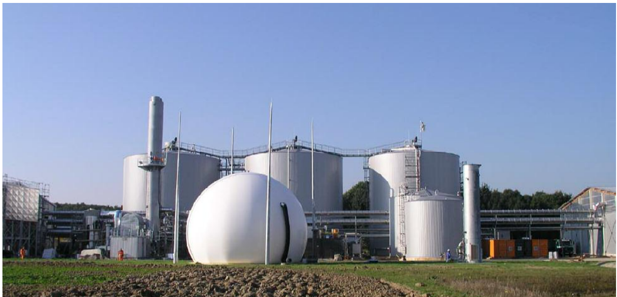
Abbildung 2 Bei der MBA Lübeck gibt es konzeptionell sehr wenig Abluft zu reinigen: 60.000 m 3 /h Abluft bei 17 t/h Abfall The amount of exhaust air to be treated at Luebeck MBT plant is conceptually small: 60,000 m 3 /h of exhaust air while processing 17 t/h of waste
